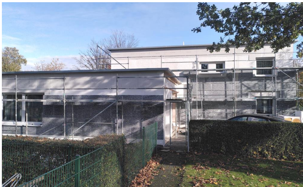
Energetische Sanierungsmaßnahmen am Pfarrhaus West.
