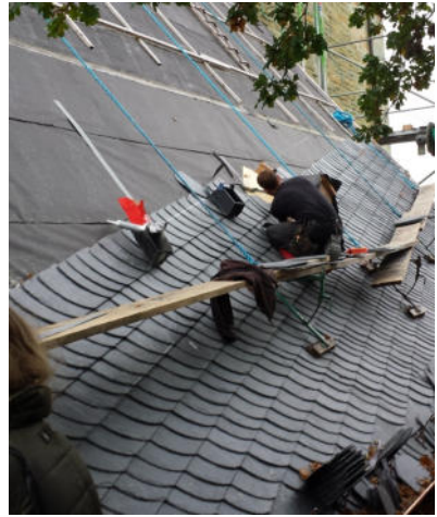
Die Dacharbeiten an der Nordseite gehen zügig voran
