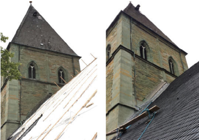
Juni 2017: Süddach im Bau, mit Folie Oktober 2017: das fertige Dach
