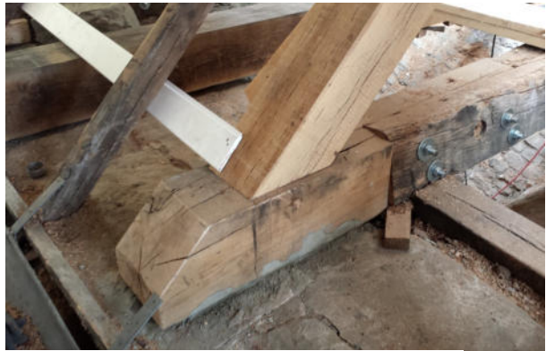
Fachgerecht sanierter Fusspunkt an der Südseite
