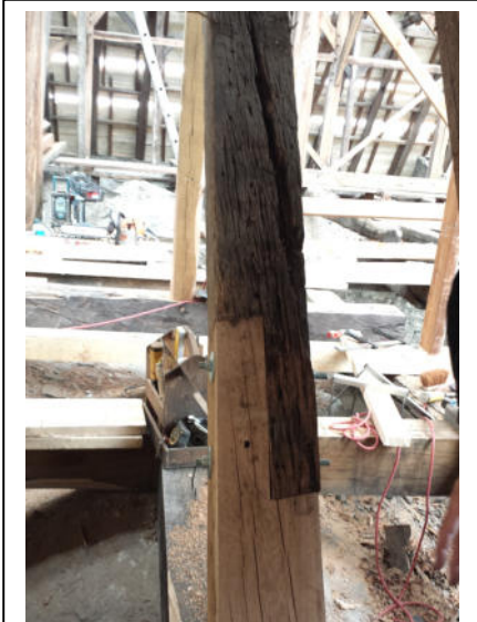
Ausbesserung eines mittelalterlichen Sparrens
