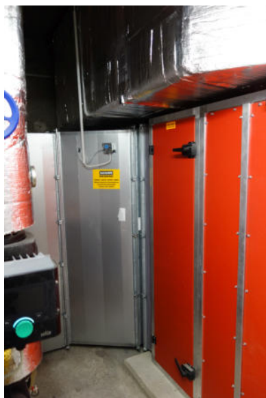
In einem weiteren Raum dahinter befindet sich die Anlage der Fa. MAHR. Von hier geht die Warmluft in die Kirche. Im mittleren Bild ein Gebläse. Die Aufteilung der Räume wurde neu vorgenommen. Alte Wände wurden herausgenommen, neue aufgemauert.
